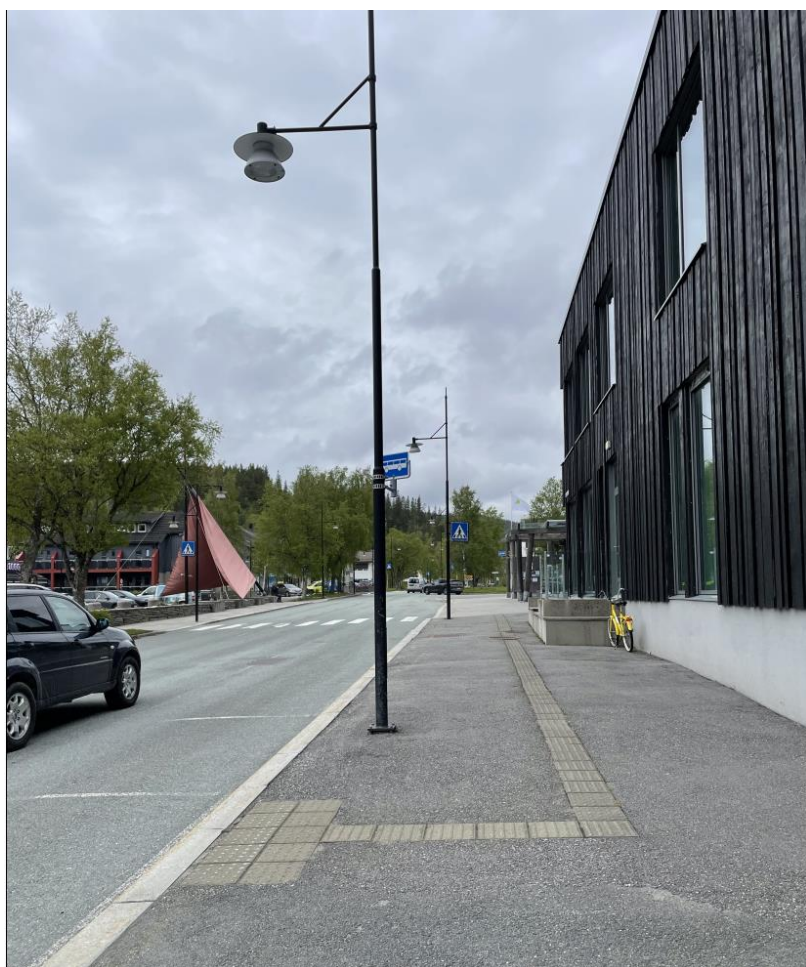
Figur 27 Oppstillingsplass for buss med taktile heller på plattform
