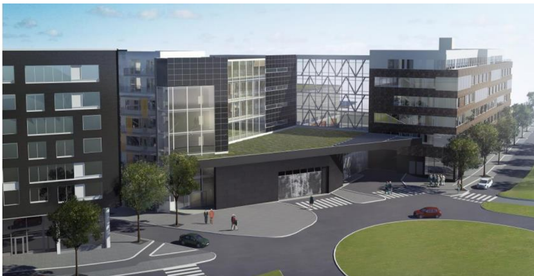
Figur 4-5: Totalt er bygningen på 50.000 kvadratmeter med bussparkering i 1.etasje, bilparkering og servicefunksjoner i 2.etasje (delvis under bakken), drivstoff, vask og verksted i 3.etasje, og kontorer i etasjene 4-7. Første spadetak ble tatt i 2012, og prosjektet forventes ferdig 2017. Kostnaden var ca 1,3 mrd SEK. Skanska.
