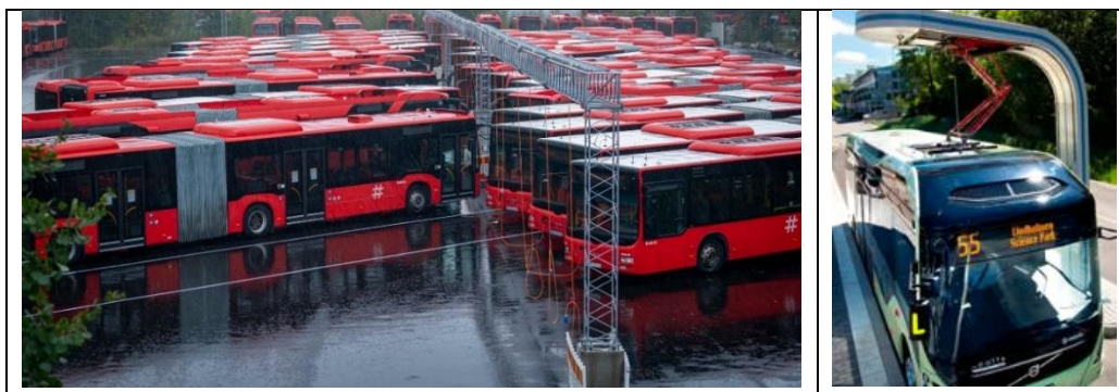
Figur 6-10: Bussdepot i Oslo. Kilde: Ruter. Bilde to viser eksempel på pantograf ved endeholdeplass. Kilde Siemens/TU
