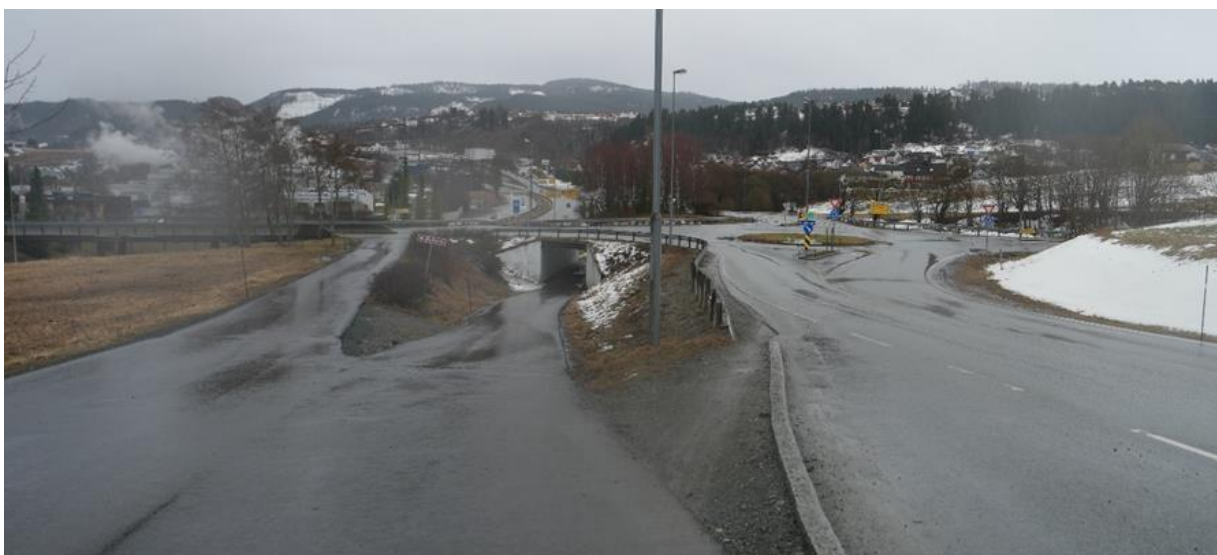
Figur 3-6: Bilde av krysset Kockhaugveien/Presthusveien. Foto: ASplan Viak
